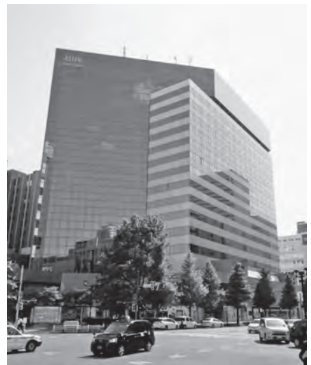
札幌駅前のアスティ45ビル（事務所は7階）
