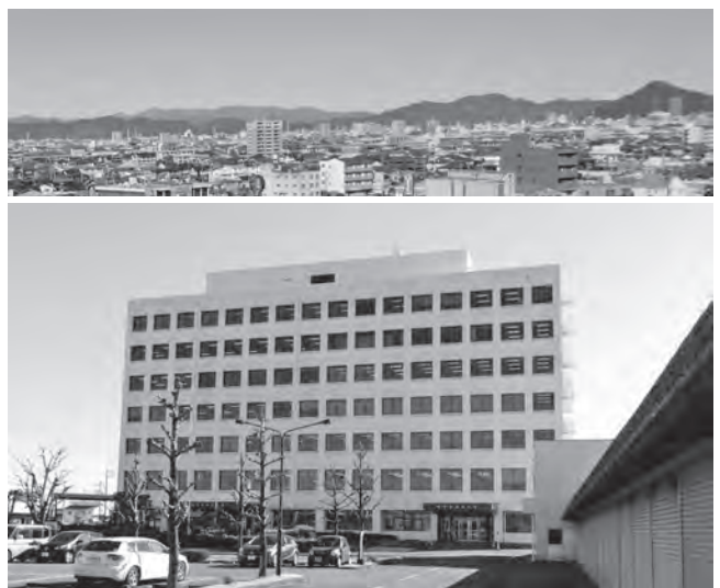
健保組合はビルの7階に。眺望(写真上)が素晴らしい。
